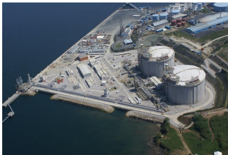
Figure 1. Example of layout of LNG terminal. Reganosa LNG Terminal, Spain.
